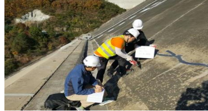
발전소 및 수리시설
