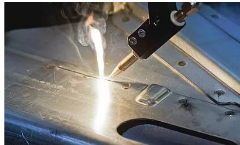
알루미늄 및 금속 용접
